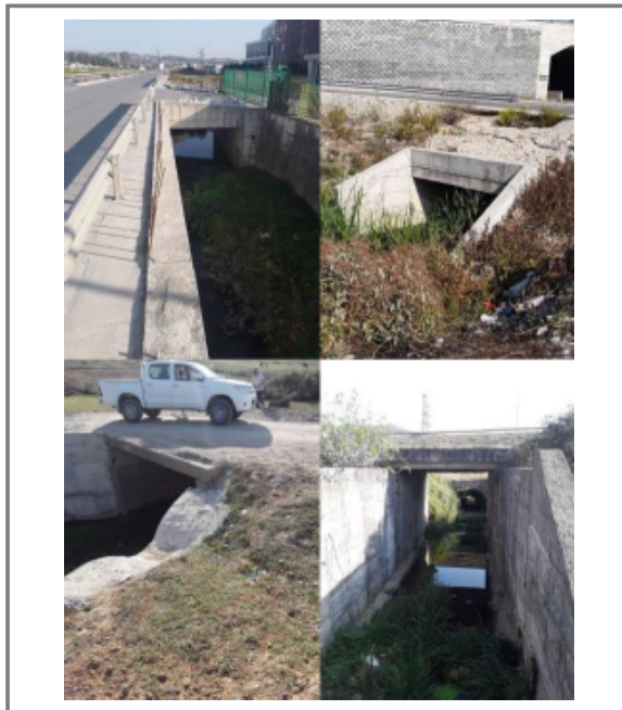
“Culvert” (Strukturë betoni)
